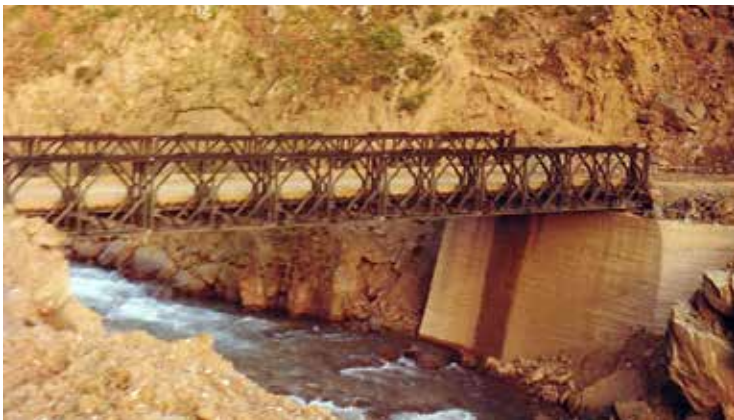
Η στρατιωτική γέφυρα μπέλευ από τον Άσπρο που έπρεπε να έχει στηθεί ήδη στα έτοιμα βάθρα της θέσης «Ρογκάκια» του δρόμου Νεραΐδας – Καροπλεσίου...
