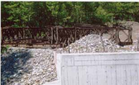
Τατσιμεντένια βάθρα περιμένουν ακόμα να στηθεί πάνω τους η γέφυρα.
