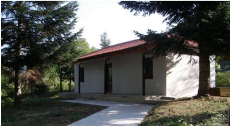
Το νέο Οστεοφυλάκιο Νεραΐδας, όπως είναι σήμερα και φαίνεται από την νοτιοδυτική γωνία, με τον τσιμεντένιο διάδρομο.
