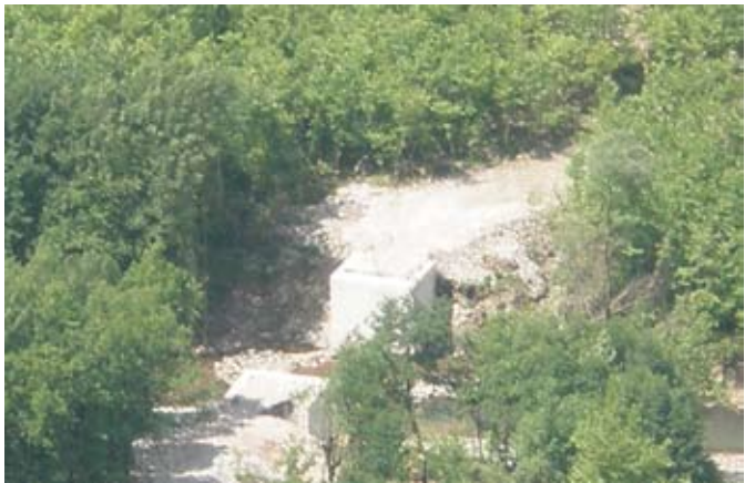
Τα τσιμεντένια βάθρα της γέφυρας του δρόμου Νεραΐδα – Καροπλέσι, στη θέση «Φιλίππου». Αληθεύει ότι η μελέτη προέβλεπε κατασκευή βάθρων, μεταφορά και τοποθέτηση της γέφυρας από τον ίδιο εργολήπτη; Αν ναι τότε θα τοποθετηθεί αυτή η γέφυρα; Ζητάμε επειγόντως απάντηση από τους αρμοδίους γι' αυτό.
